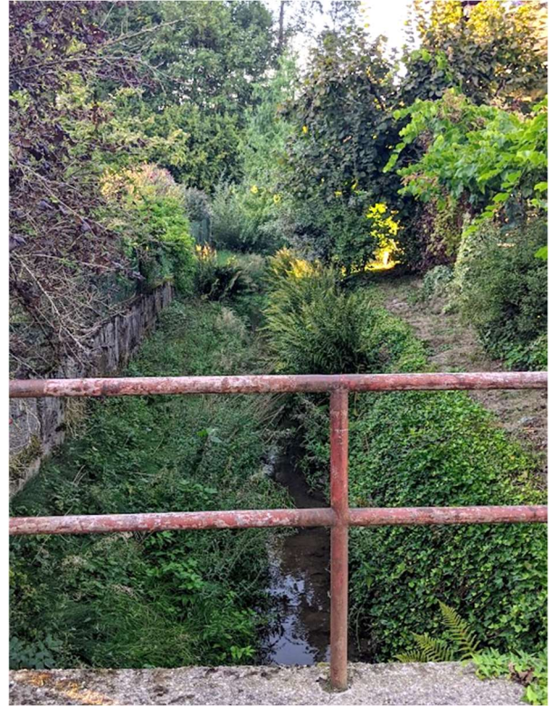
Abbildung 13: Ausgebauter Bachlauf Linnenbach mit Brücke am Hauswiesenweg, Blickrichtung Nordwest
